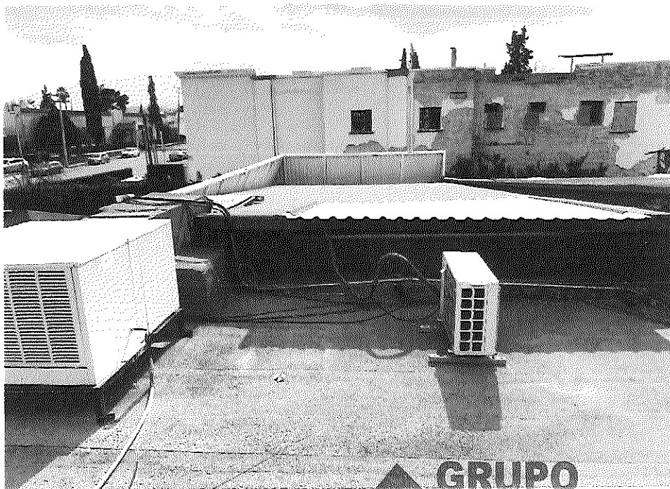
VISTAS DE EQUIPOS EN AZOTEAS.
