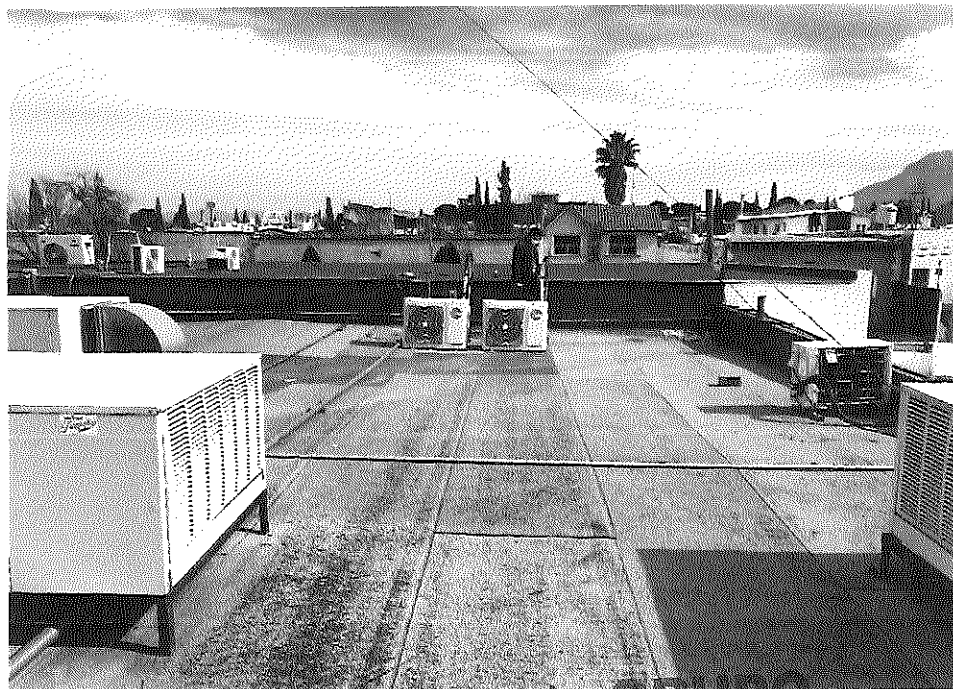
VISTAS DE EQUIPOS EN AZOTEAS.
